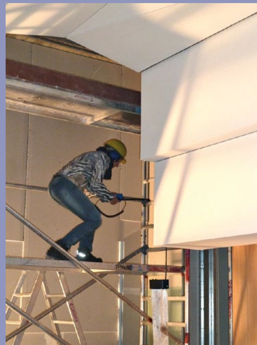
Hochfrequente Dichtheitsmessungen beim Musterbau
