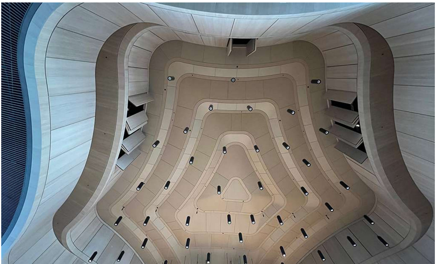
Blick zur Saaldecke; das Foto ist nicht schief, vielmehr ist der Grundriss leicht unregelmäßig. Rechts und links oben sind die beweglichen Paneele zu sehen. (Bild: Ursula Baus)
